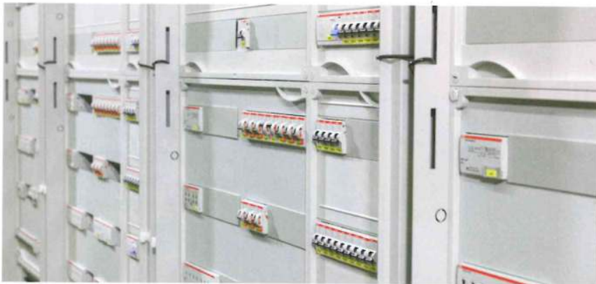
Auch komplexe Projekte mit mehreren Schaltschrankfeldern lassen sich mit Epos bearbeiten – zeitsparend und immer verknüpft mit ERP und der Fertigungsebene.
